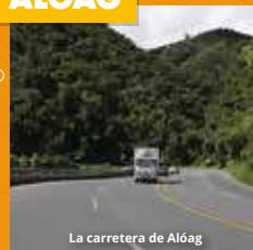
La carretera de Alóag
